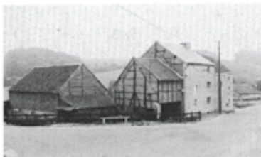
Tohogne. Longueville. Démolitions partielles. Les volumes subsistants restent beaux mais leur continuité n'existe plus. Un poteau bien mal placé.
