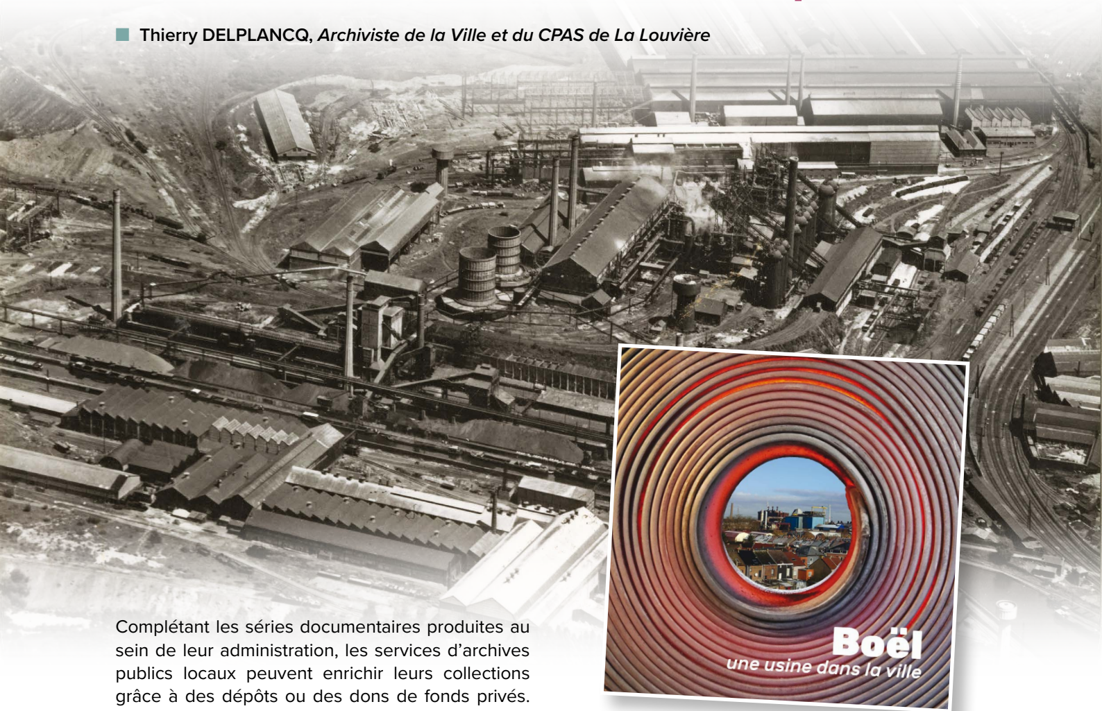
Couverture de l'ouvrage sur Boël
