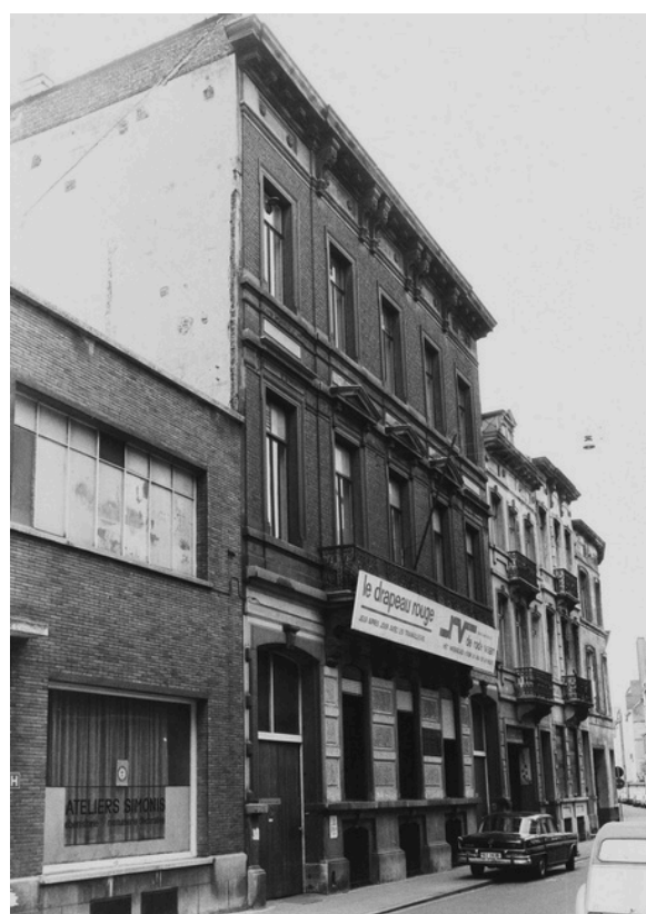
Facade, rue de la caserne 33
